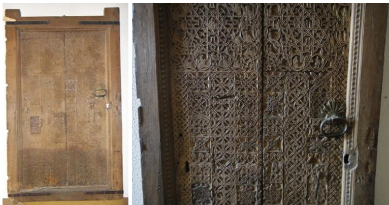
Сл. 2: Еднокрилна дрвена резбана врата од Слеченскиот манастир: а) еднокрилна врата; б) изглед на резбата и елемент за отворање (извор: од личната колекција на авторот, 6.10.2016 година)
