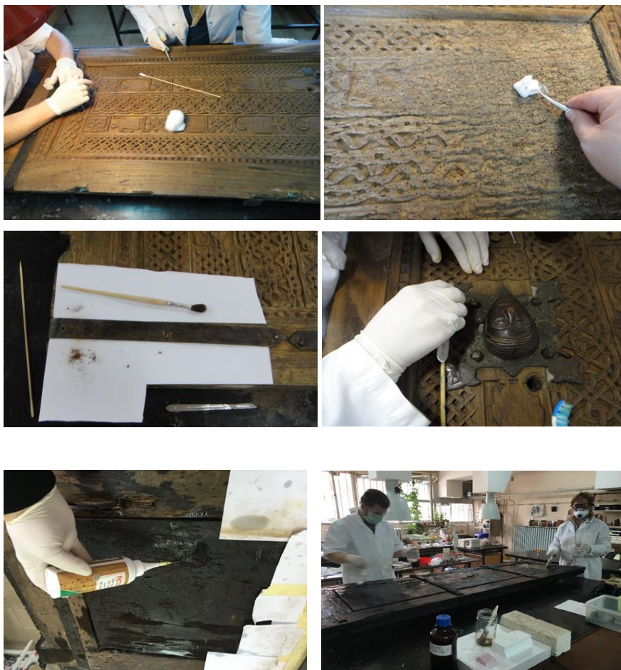
Сл. 6: Реализација на непосредна заштита кај дрвените врати во ЦКЛ (извор: од личната колекција на авторот, 20.12.2016 година)
