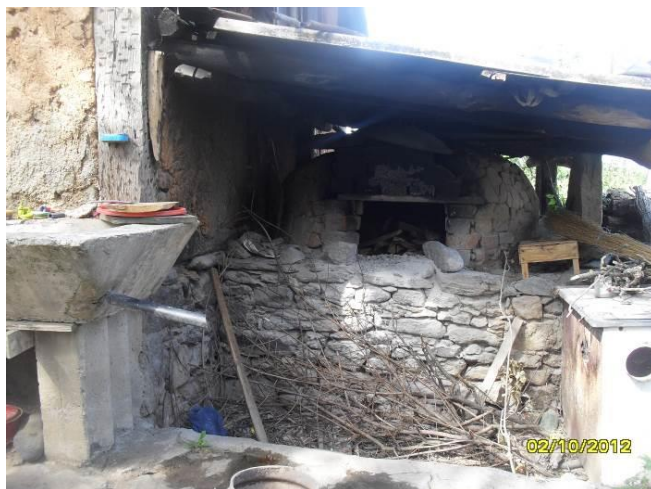
Фотографија бр. 9. Фурна за печење леб која има форма на купола. Фурната е поставена до ѕид од куќата и е покриена со натстрешница од салонитки, с. Мождивњак.
