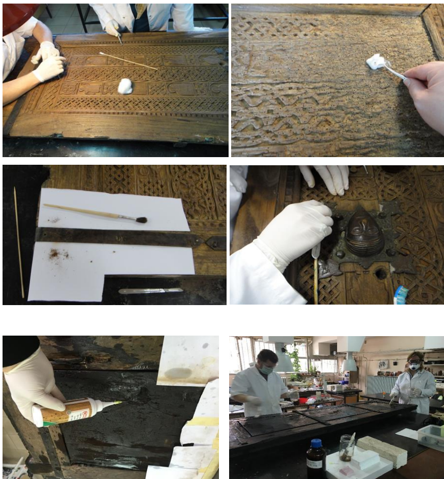
Сл. 6: Реализација на непосредна заштита кај дрвените врати во ЦКЛ (извор: од личната колекција на авторот, 20.12.2016 година)
